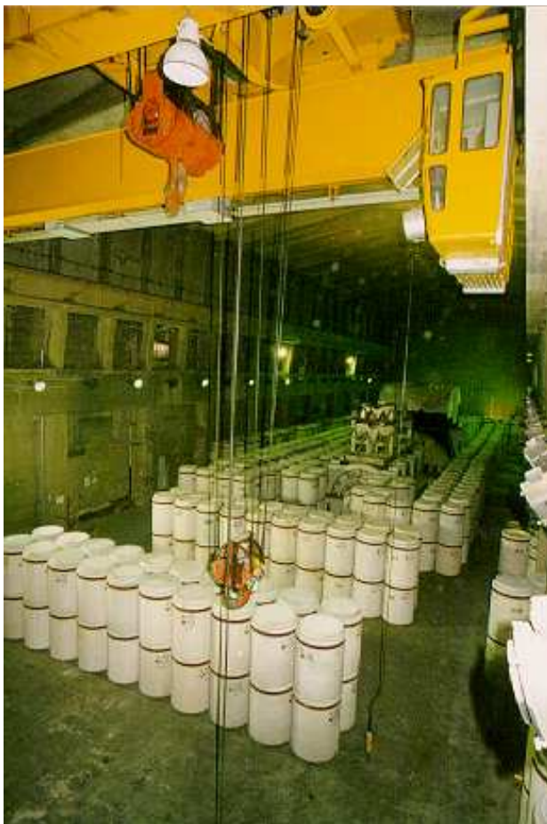
Stoccaggio temporaneo dei rifiuti condizionati nell'edificio turbina
