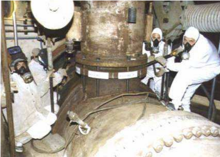
Smontaggio delle condotte primarie
