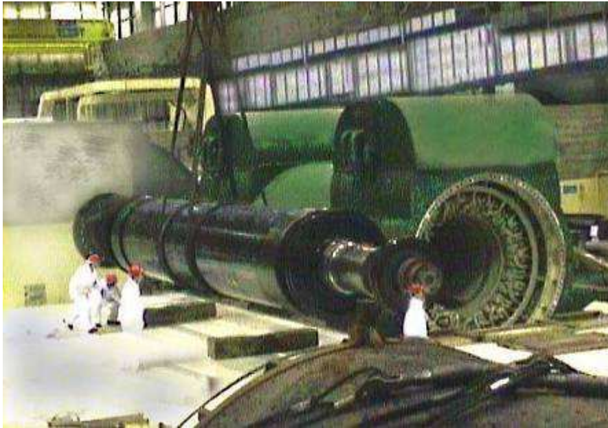
Smantellamento dell'alternatore
