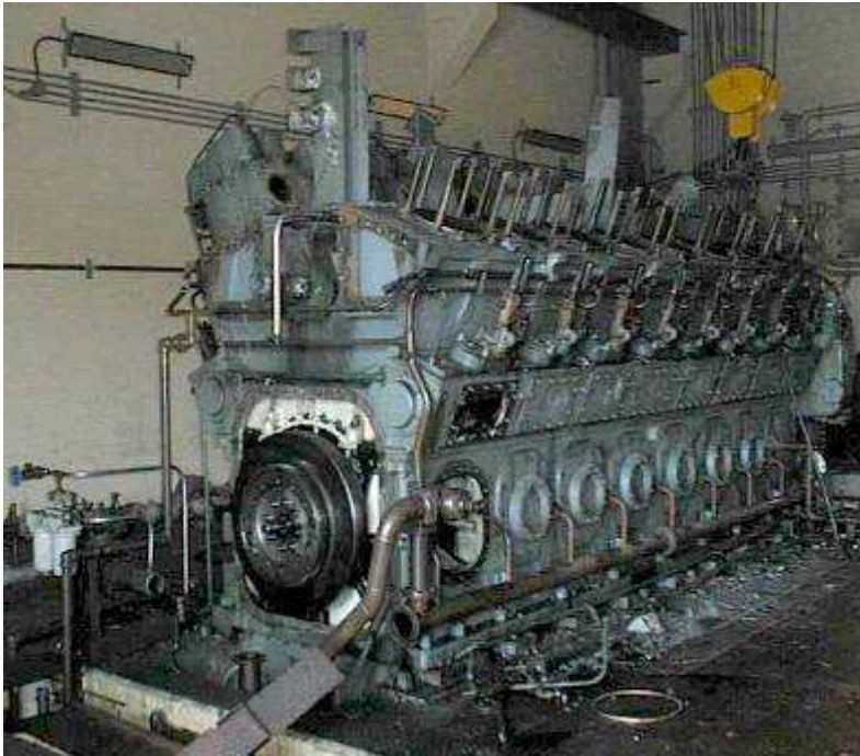
Smantellamento dei diesel di emergenza.
