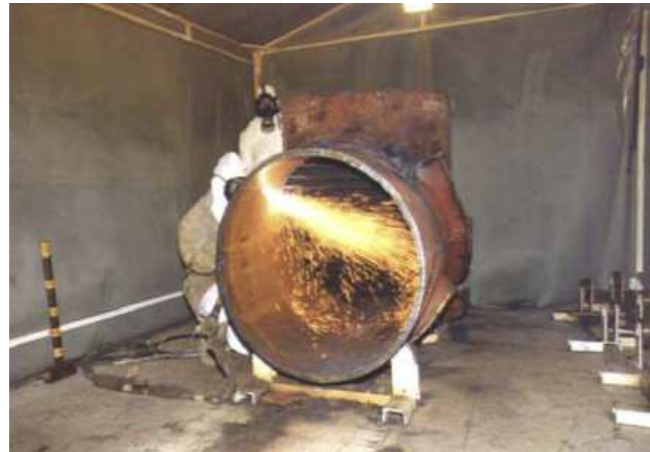
Segmentazione delle condotte primarie
