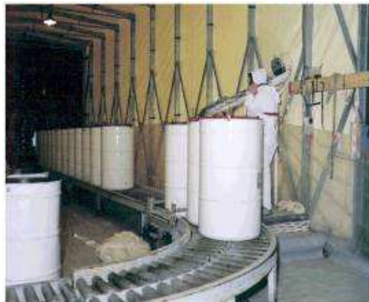
Cementazione fusti supercompattati in "overpack"
