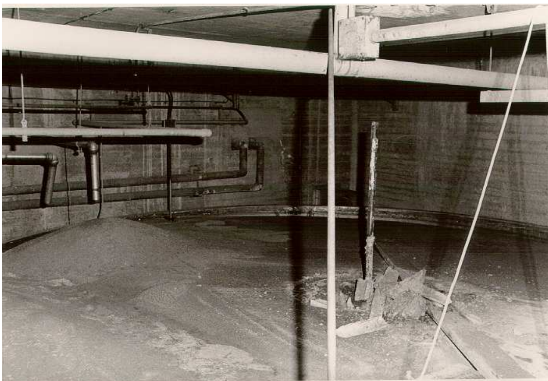
Interno di un serbatoio interrato
