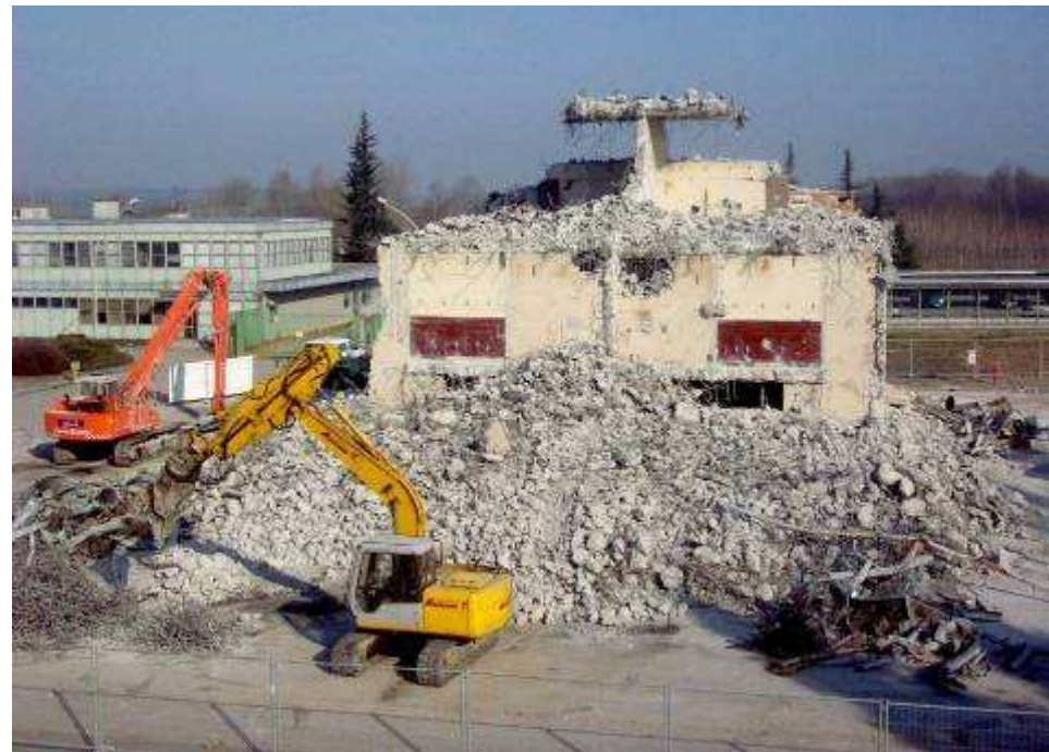
Demolizione dell'edificio diesel di emergenza.
