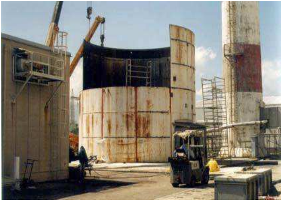
Smantellamento del serbatoio
